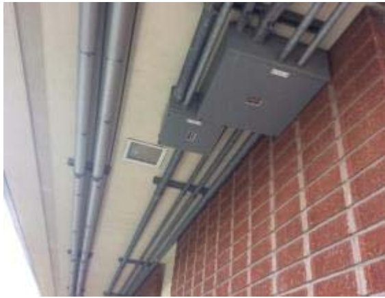
Photo #39: Electrical Wiring Conduit
